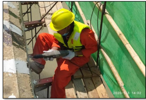
Rebar Stapler Pin Hook တပ်ဆင်နိုင်ရန် အပေါက်များ ဖောက်နေပုံ
