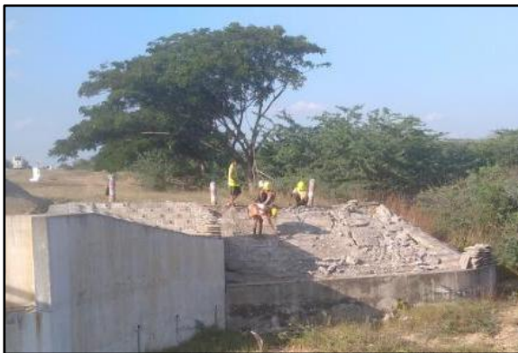
Toe wall လုပ်ငန်းဆောင်ရွက်နေပုံ
