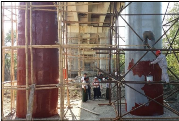
တံတားတိုင်ပျက်စီးမှုအား ဆေးငွေ့ရှိက်ခြင်းမှ ကာကွယ်နိုင်ရန် Epoxy Coating သုတ်လိမ်းနေပုံ
