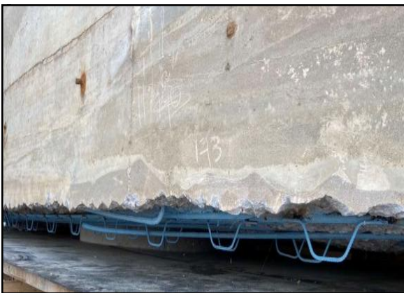
သံချေးခံဆေး Anticorrosive Paint သုတ်ခြင်းနှင့် Shear Key တပ်ဆင်ခြင်းလုပ်ငန်း ဆောင်ရွက်ထားပုံ
