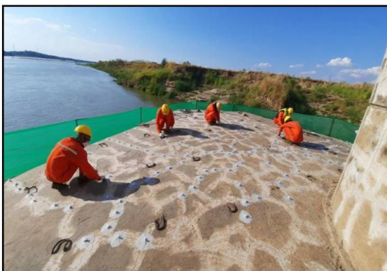
Epoxy Syringe Injector Nozzle များကို Epoxy ကော်အသုံးပြု၍ တပ်ဆင်ပေးနေပုံ
