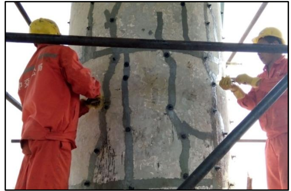
Epoxy Resin ဆေးရည်များအား Pressure ဖြင့် ထိုးသွင်းပြုပြင်နေပုံ
