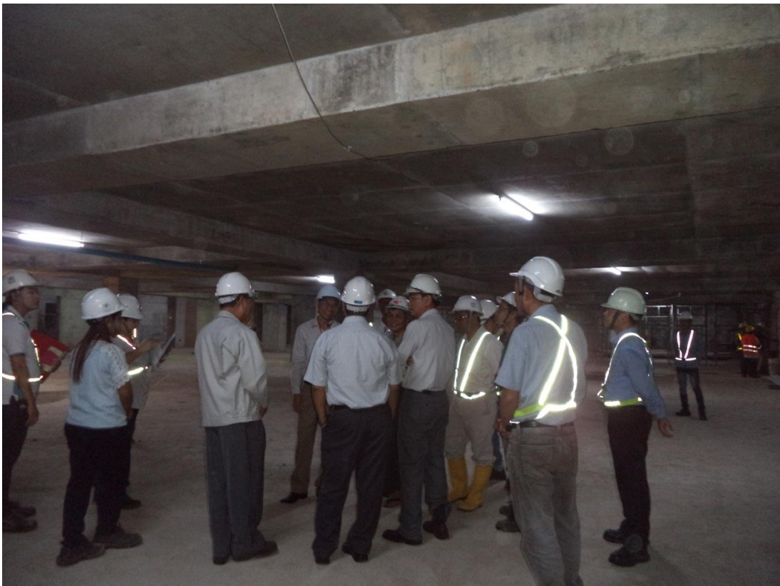
မျက်မြင်စစ်ဆေးလေ့လာမှု (Visual Inspection) ဆောင်ရွက်မှုများ
