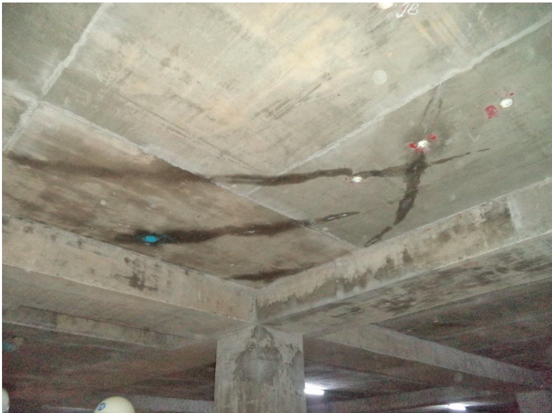
မြေညီထပ်ကြမ်းခင်းအောက်ခြေရှိအက်ကွဲကြောင်းများ
