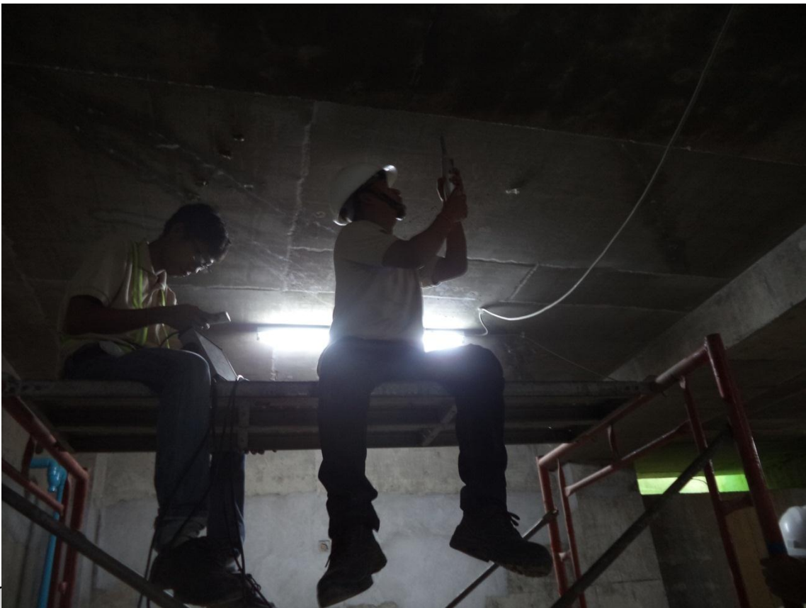
Rebound Hammer Test ပြုလုပ်ခြင်း
