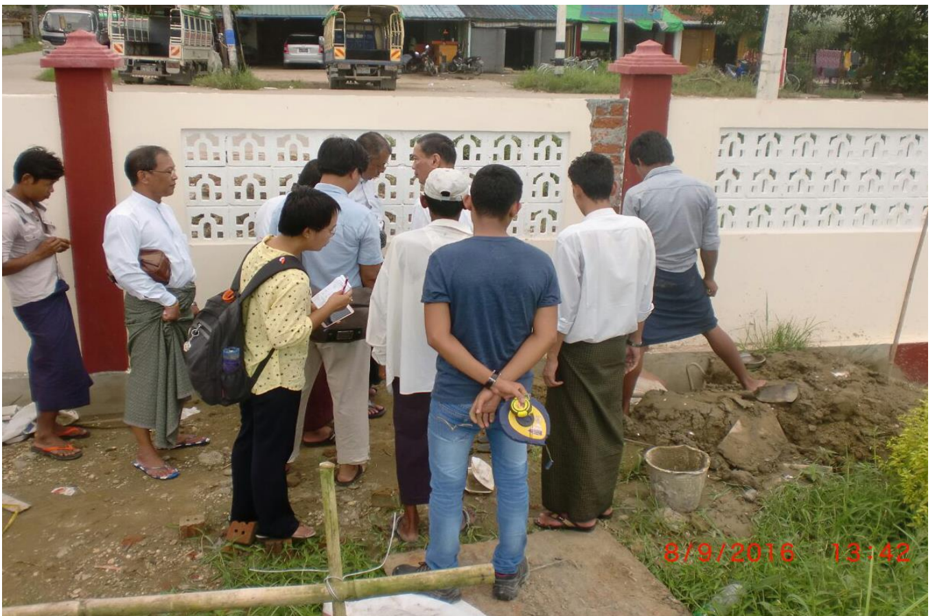
Fencing အား ၎်လက်မခန့် ထွင်းနေမှုအား ကြည့်ရှုစစ်ဆေးနေပုံ
