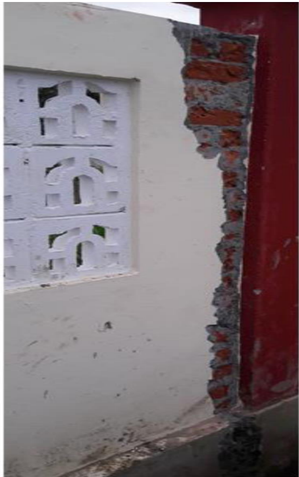
Drawing နှင့် ကိုက်ညီမှု မရှိဘဲ RC Beam တစ်ခုသာ ထည့်ထားကြောင်း တွေ့မြင်ရပုံ
