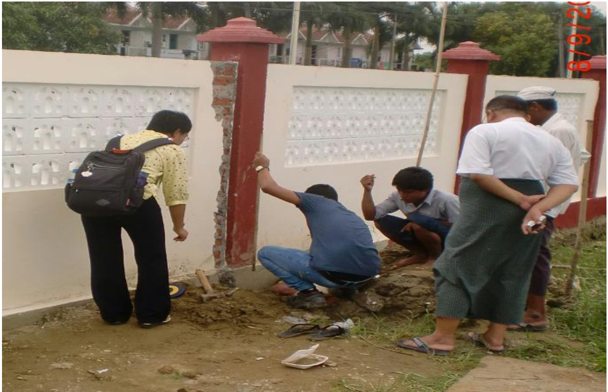
၄ လက်မခန့် ထွင်းပြီးနောက် Drawing နှင့် ကိုက်ညီမှု ရှိ/မရှိ တိုင်းတာ စစ်ဆေးနေပုံ
