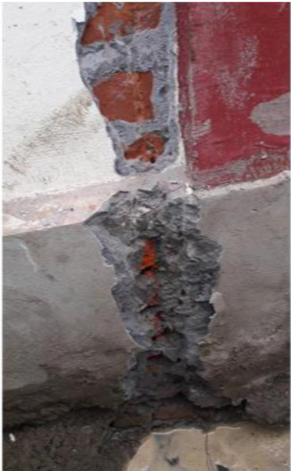
Drawing နှင့် ကိုက်ညီမှု မရှိဘဲ RC Beam တစ်ခုသာ ထည့်ထားကြောင်း တွေ့မြင်ရပုံ
