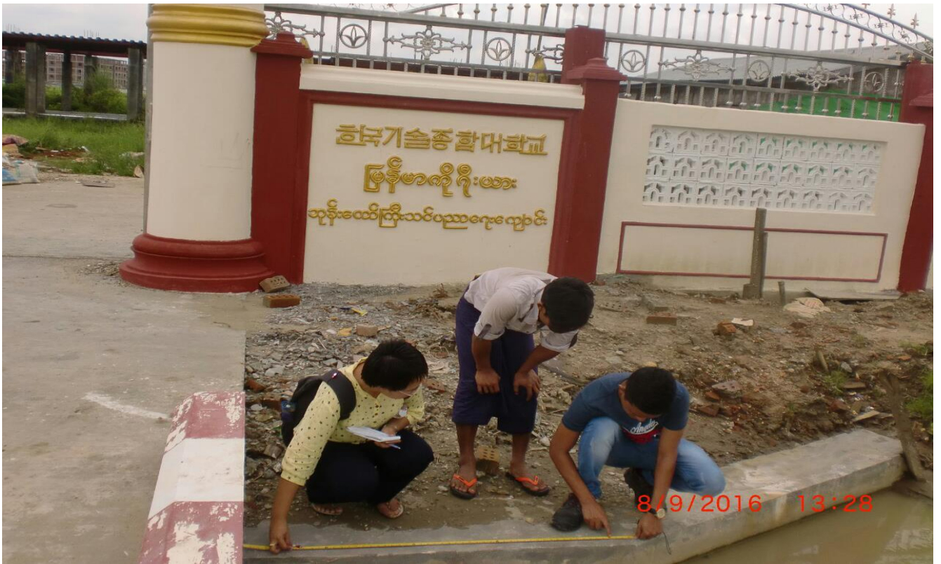
RC Culvert ၏ အတိုင်းအတာအား တိုင်းတာနေပုံ
